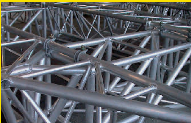
Unterkonstruktion für Podeste zur Wartung von Wasserkraftwerken
